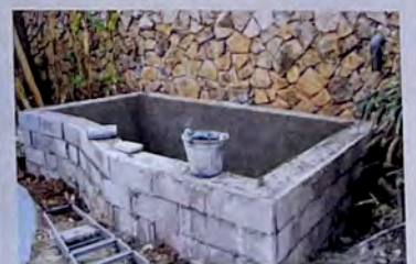
Bau der Zisterne, April 2013
